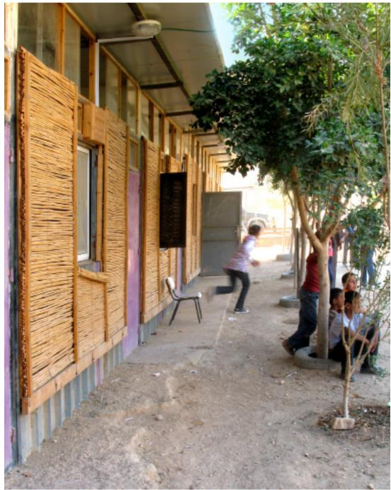
**本页, 左上, 顺时针:** 贝都因小学 曾经是由金属板围合而成的简易 结构。图中展示建筑改造工程的情 况:建筑改造初期;意大利建筑团 队人员爬上建筑的支撑结构, 与当 地居民合作建造: 教室内部结构改 浩.墙体采用了竹材.因为竹材具 有很好的透气性;教室地板结构的 建造
